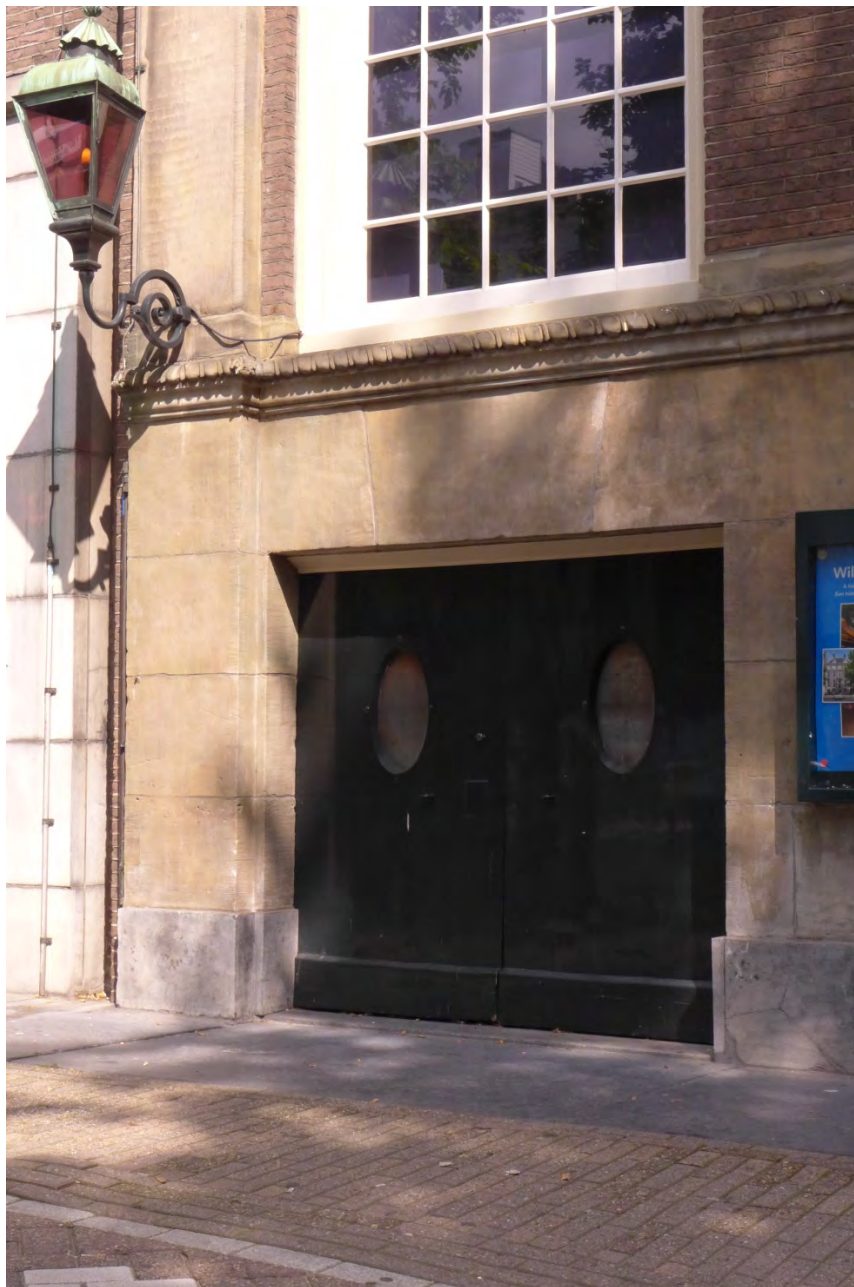
Afb. 23 dubbele zijdeuren van buiten
