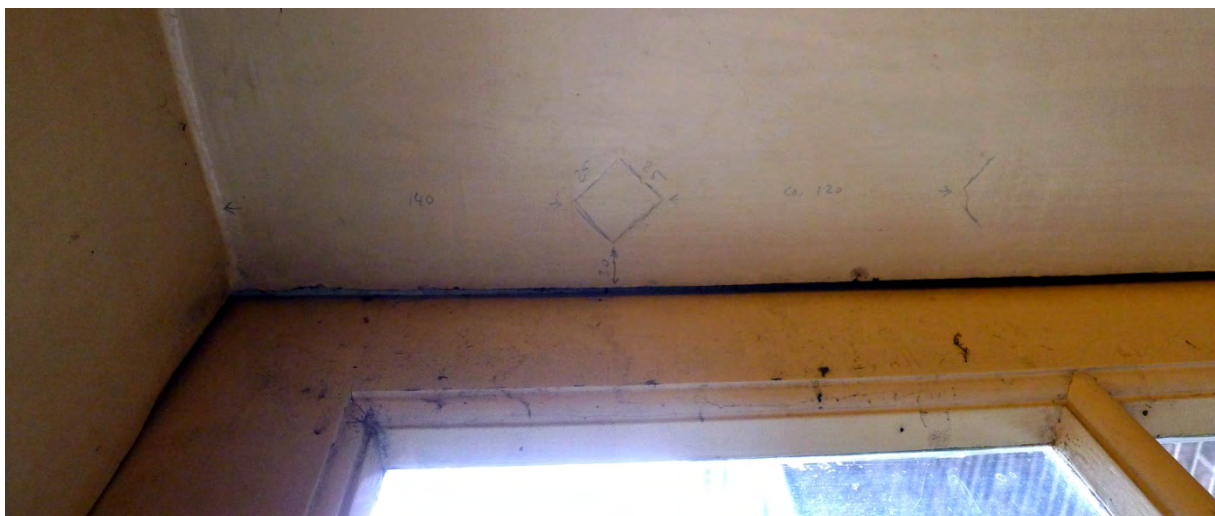
Afb. 31 Detail van kozijndorpel met sporen van de oude tralies
