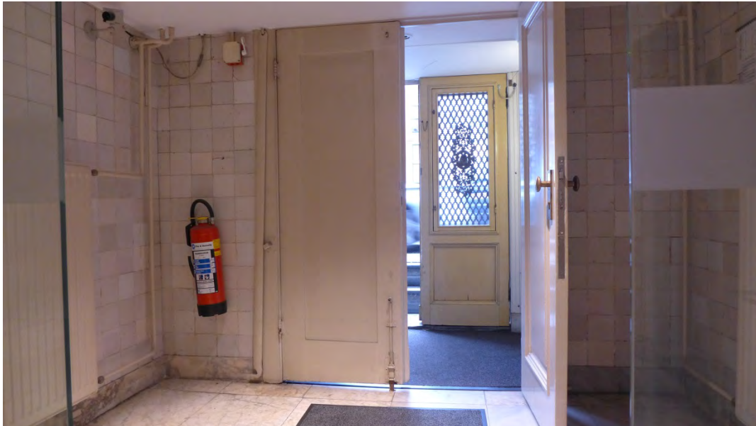
Afb. 10 dubbele deuren na voordeuren
