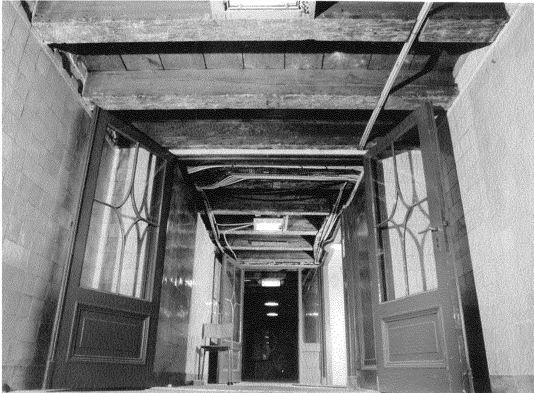
Afb. 16 De bekabeling en plafondverlichting uit 1969 opnieuw in het zicht tijdens de renovatie van 1996
