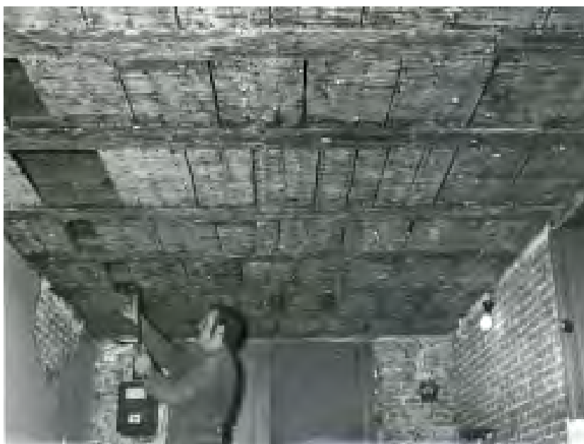
Afb. 15 De eerste sloop van het plafond in 1969
