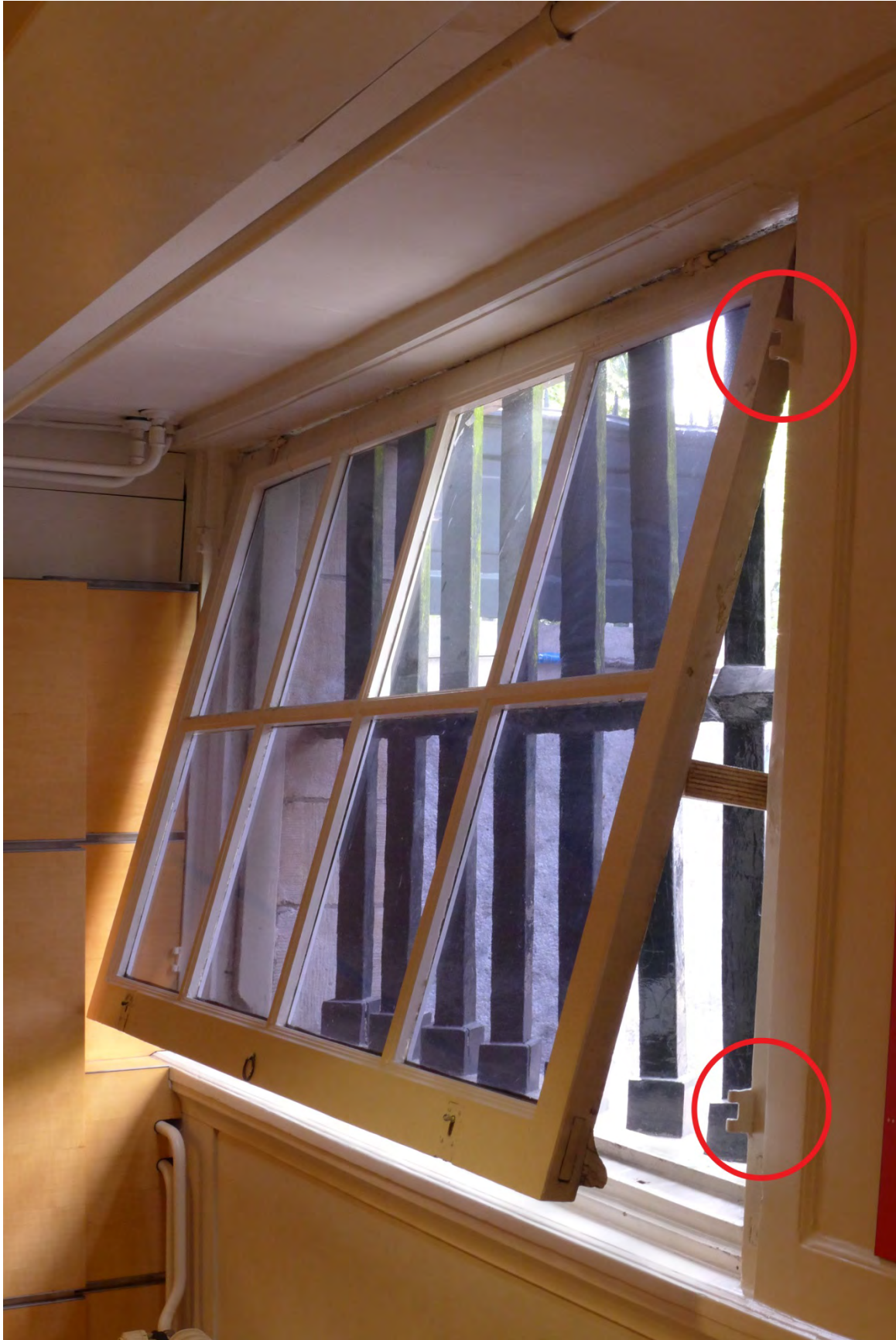
Afb. 22 Kozijn en raam van voormalige spreekkamer, nu portiersloge met scharnierrestanten omcirkeld
