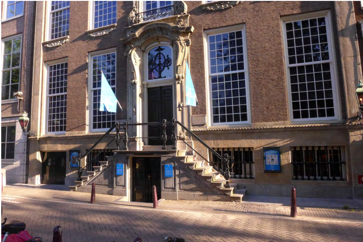
Afb 1. Voorgevel souterrain deel
