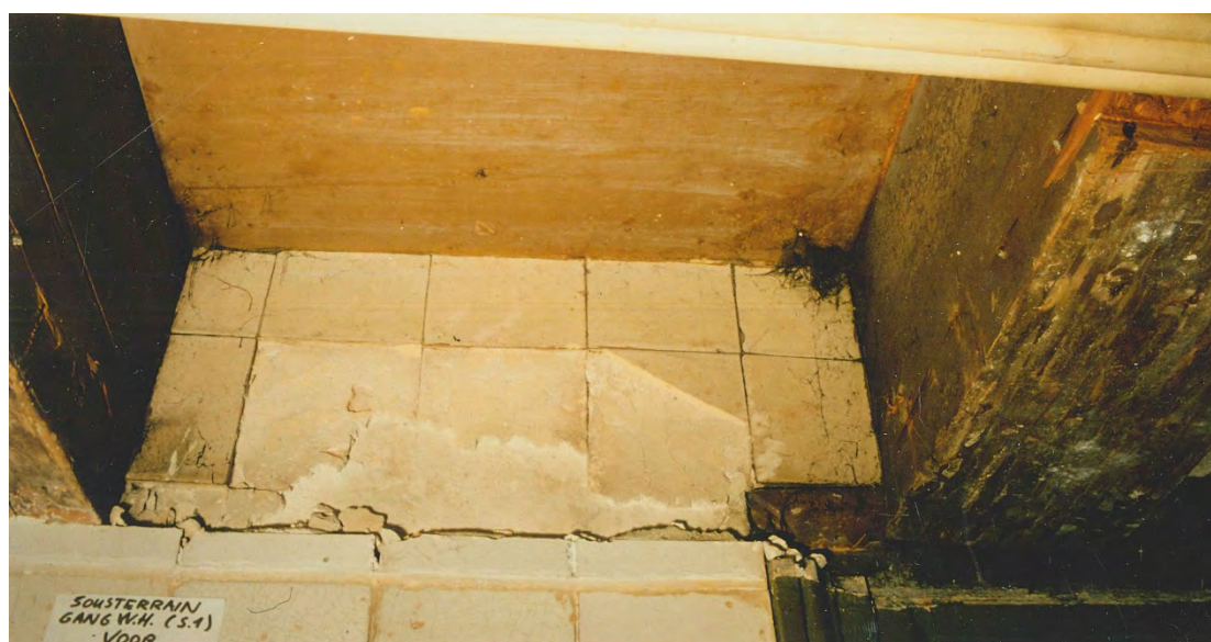
Afb. 18 In het achterste deel van de gang was slechts oude witkalk en stuc boven het moderne plafond
