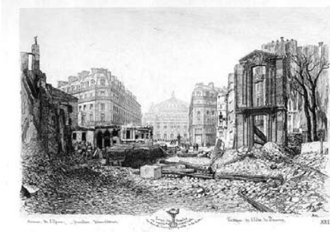
4. Clearing of the Avenue de l' Opéra
