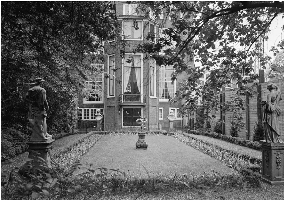
Afb. 15 In 1966 worden het belendende pand van Herengracht 603 en ook het Centraal theater, de opvolger van het Panopticum wordt gesloopt en een hoge schutting verrijst langs de bouwplaats.
