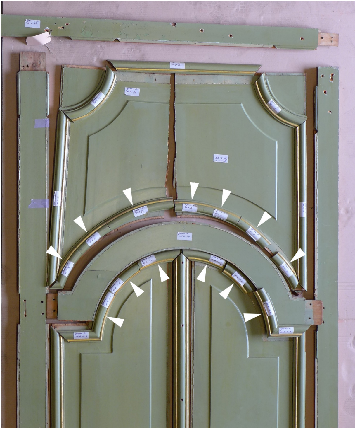
Afb. 22 Het grotendeels vernieuwde lambriseringschot van de achterwand heeft nog wel de authentieke eiken profiellijsten, die tot korte stukken verzaagd zijn om ze opnieuw pas te maken.
