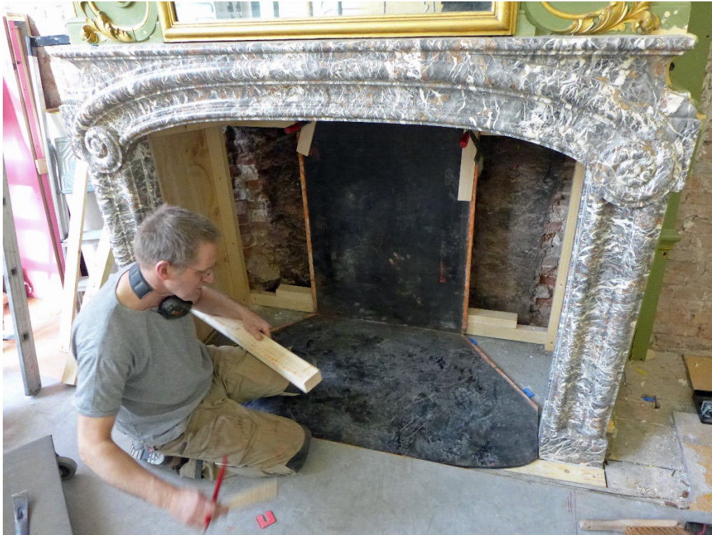
Afb. 34 De inbouw van de haardplaten
