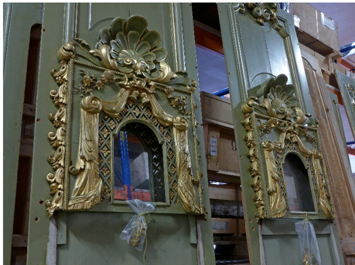
Afb. 14 Een penantschot met geopend deurtje met daarachter ruimte voor een uurwerk (spiegeltje en achterschot zijn nieuw).
