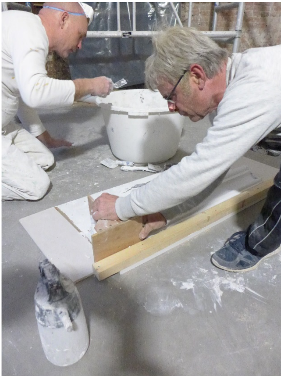
Afb. 32-33 Vervaardiging van een ontbrekend gedeelte van het stucprofiel voor aansluiting op de kroonlijst van het plafond.
