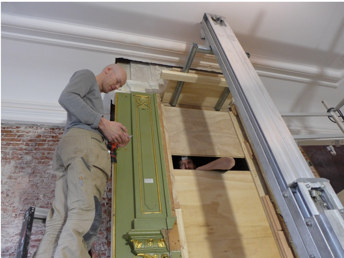
Afb. 27-29 Constructie van het draagframe voor de boezem en de montage.
