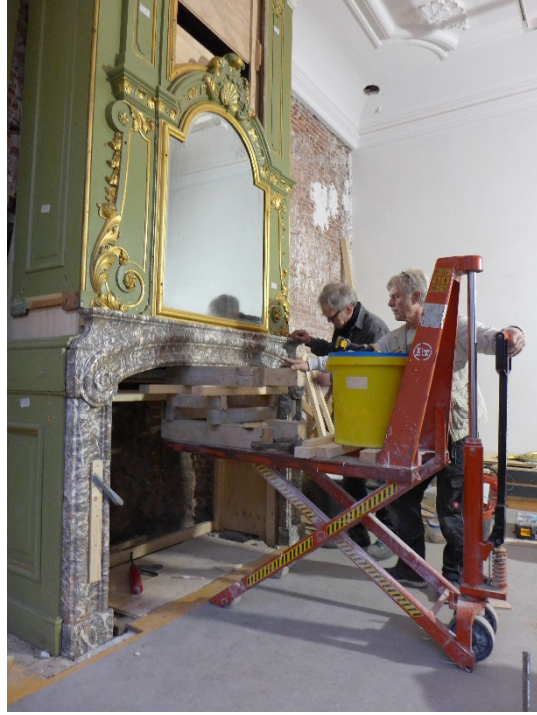
Afb. 31 Plaatsing van de gerestaureerde marmeren schoorsteenmantel
