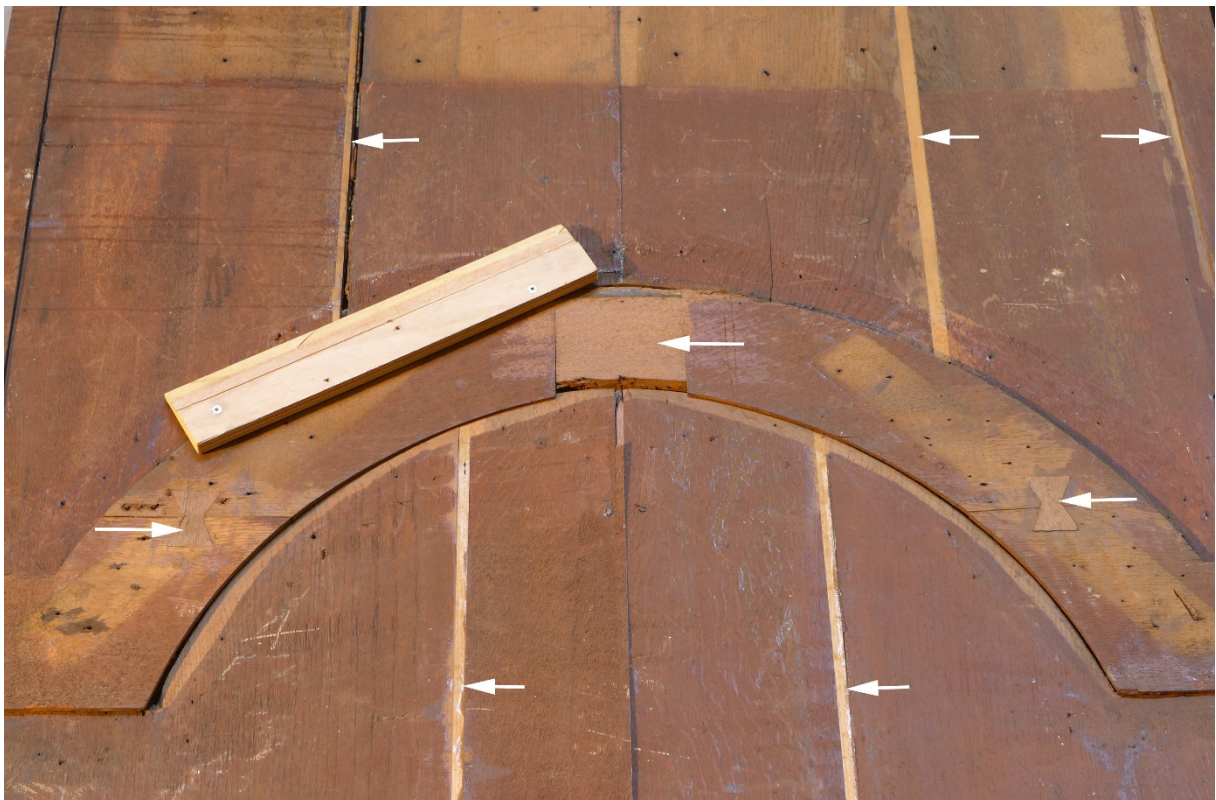
Afb. 21 Detail toogvorm aan de achterzijde van een lambriseringsschot. De lichtgekleurde ongeverfde reparatie stukken in de halfronde bovenregel en langs de mes-en-groef verbindingen in de panelen zijn gemarkeerd.
