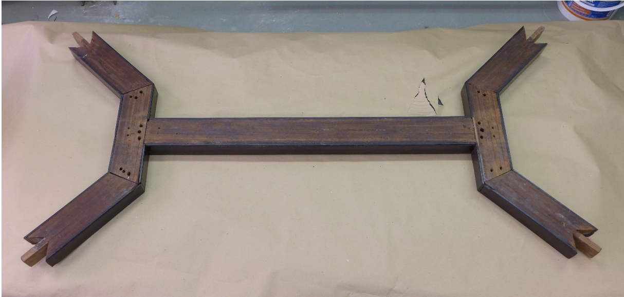
Afb. 18 Onderzijde sportenkruis met gaten voor de toognagels die de pennen borgen.
