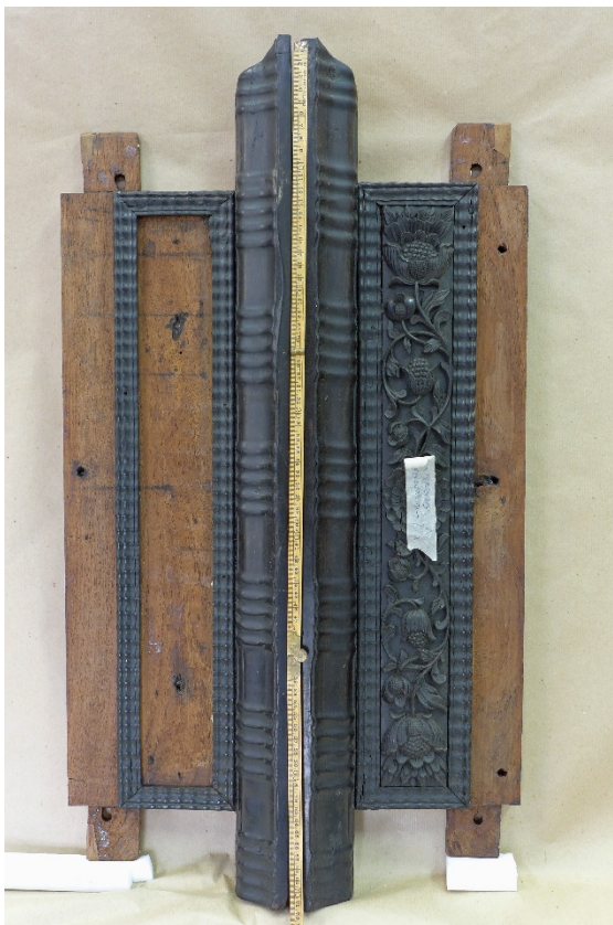
Afb. 6 Detail van robbelijsten op zijregels onderstel.
