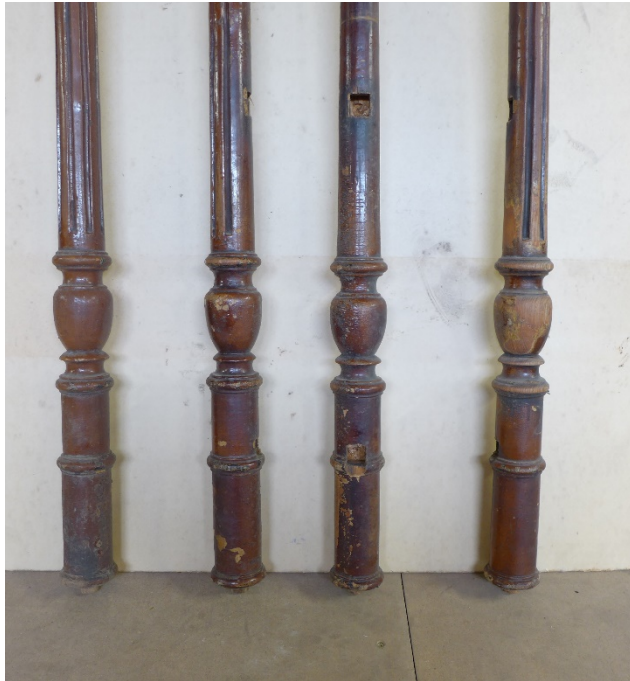
Afb. 5 Forse slijtage onderaan de kolommetjes, rechts wordt zelfs het kale hout zichtbaar.
